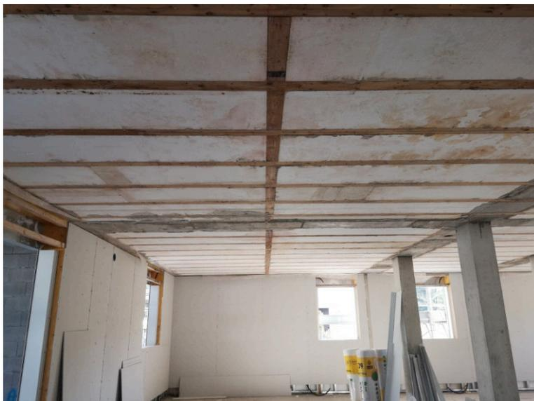
Vista dell'intradosso solaio grezzo finito – vista della maglia delle tavole di legno a soffitto atte al fissaggio cartongesso e passaggio delle canalizzazioni elettriche – vista dell'involucro esterno in opera completo di tavole di contromaschera degli infissi completi del vano del cassonetto delle tapparelle.
