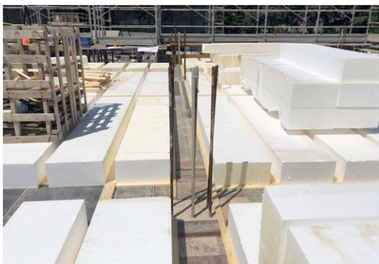
**Fasi 1, 2 e 3 VISTA dell'avanzamento in cantiere, posa dei blocchi di alleggerimento in polistirolo**
