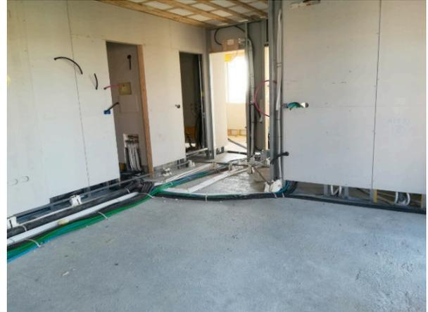
Immagine di unità con la rete delle dorsali impiantistiche completamente realizzate.
