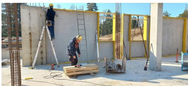
Montaggio della seconda parete con fissaggio all'altro pilastro d'angolo.
