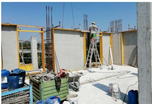
Montaggio parete di tamponamento prefabbricata fissata mediante tassellatura al pilastro d'angolo.
