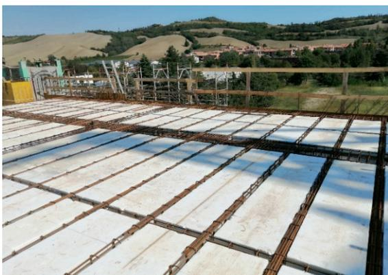
**Fasi 1, 2 e 3 VISTA dell'avanzamento in cantiere, avanzamento della posa ferri di armatura**
