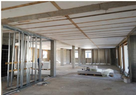
Tutti i divisori interni, comprese le contropareti del muro esterno, sono da realizzare in gessofibra, nella fotografia si può vedere il montaggio di profilati in lamiera zincata a cui fissare le pannellature delle due facce delle pareti.
