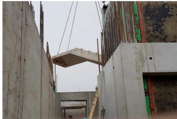
Movimentazione in cantiere con gru per posa in opera all'interno del vano scala
