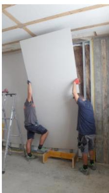
Esecuzione del tamponamento del lato interno da realizzare in gessofibra, previo montaggio di tutti i profilati in lamiera zincata a cui fissare le lastre.
