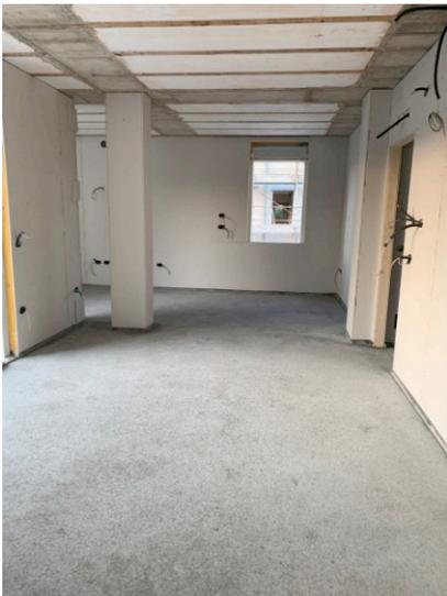
Realizzazione del primo sottofondo alleggerito (lavorazione tradizionale) per la copertura dorsali e canalizzazioni impianti
