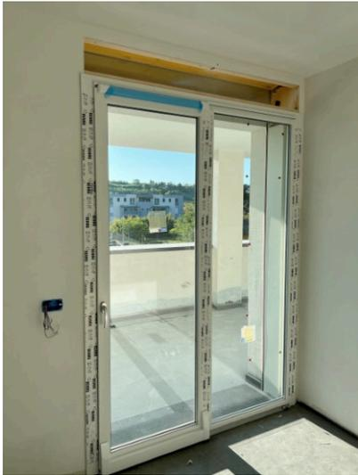
**E' già stato eseguito il montaggio delle guide tapparella e dell'infisso, il vano sovrastante predisposto risulta pronto ad accogliere la tapparella.**
