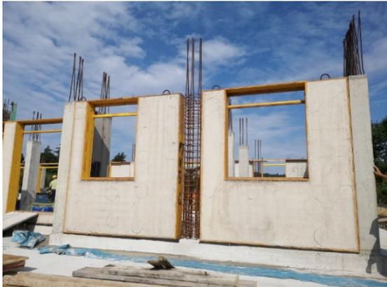
Il completamento della parete avverrà con la casseratura del pilastro centrale, i pannelli vengono fissati a quelli verticali dei lati corti delle pareti di tamponamento
