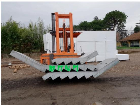
Movimentazione rampe con muletto per carico su autocarro
