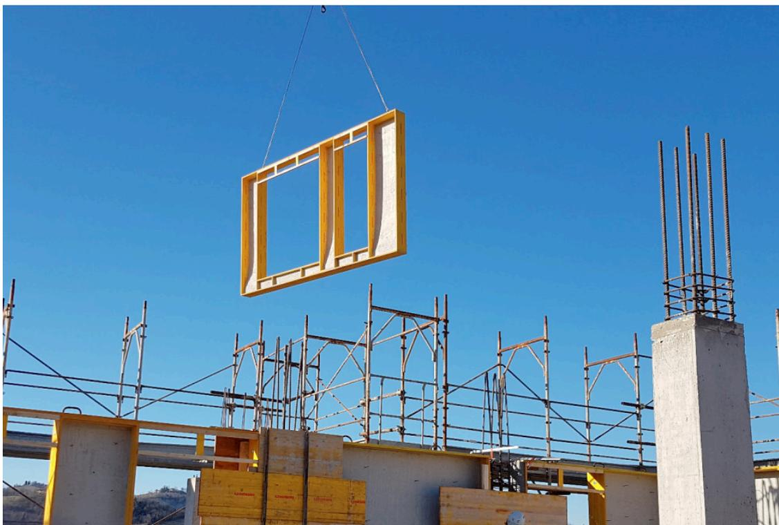
Movimentazione in cantiere, per posa in opera, con normale gru a torre.
